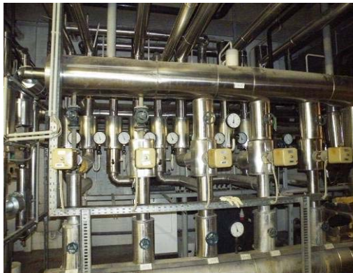
Alte Strahlpumpenanlagen
